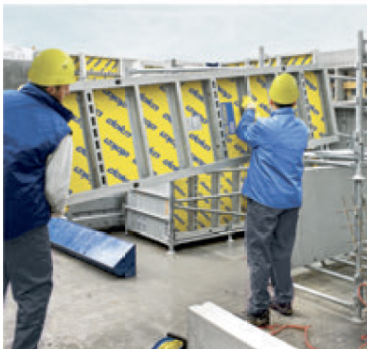
Auch auf Baustellen ohne Kranunterstützung wirtschaftlich, schnell und sicher
